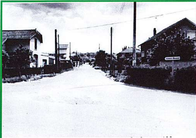
La rue du 19 janvier vue du carrefour avec la rue de Fouilleuse et la rue du Général Carrey de Bellemare. Les maisons du premier plan à droite et à gauche existent toujours.
