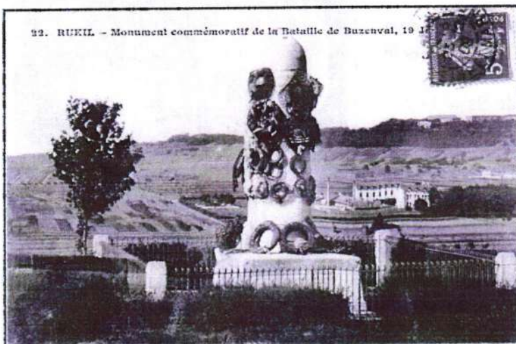
A droite du Monument, on voit les bâtiments de la colonie pénitentiaire surélevés pour augmenter la capacité.
